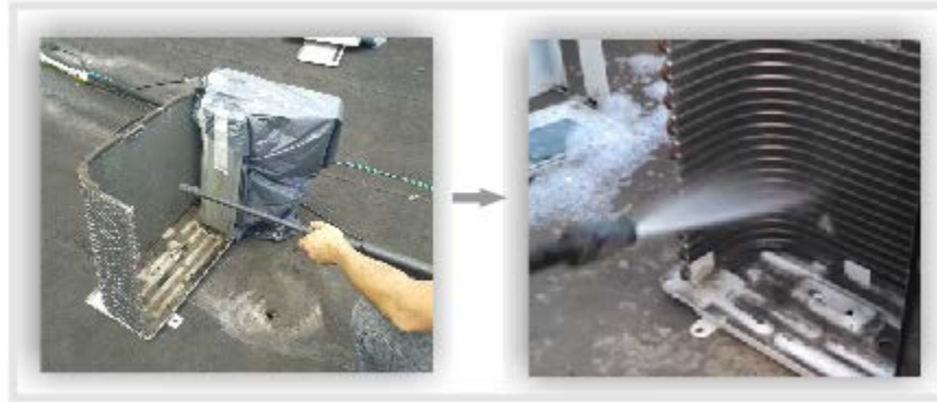
Figura 67. Limpieza de serpentín de unidad exterior.
