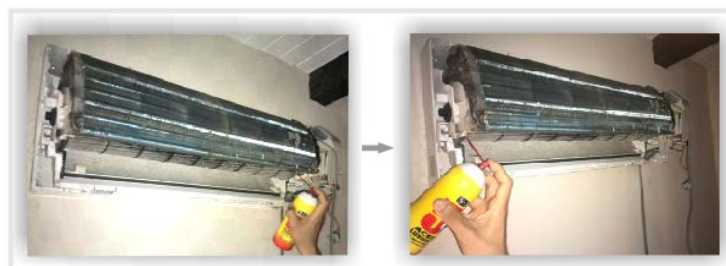
Figura 34. Lubricación de ambos extremos de la turbina
