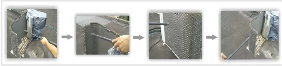
Figura 39. Colocación de la pistola del hidrojet perpendicular al serpentín.
