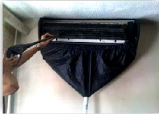
Figura 31. Colocación de bolsa colectora de agua.
