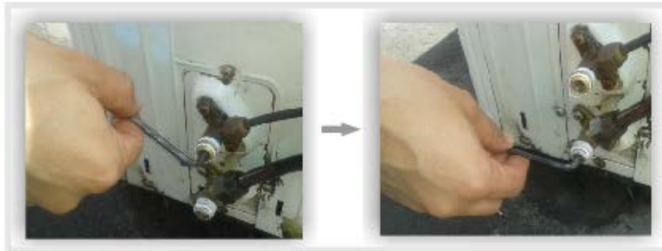
Figura 71. Liberación del refrigerante.
