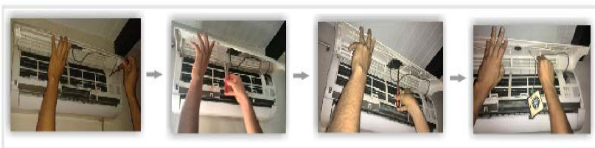
Figura 25. Retiro de tornillos de display, tapa bornera y cubierta del evaporador.
