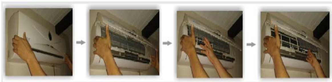
Figura 24. Retiro de filtros.
