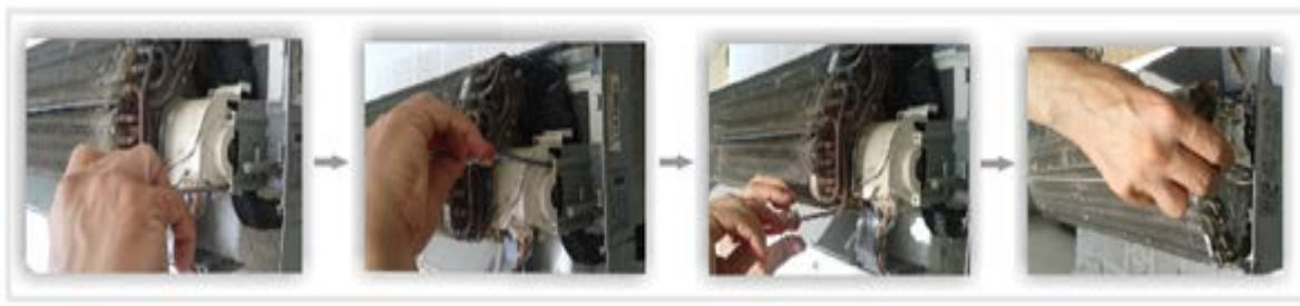
Figura 53. Retiro de tornillos que sostienen el serpentín.
