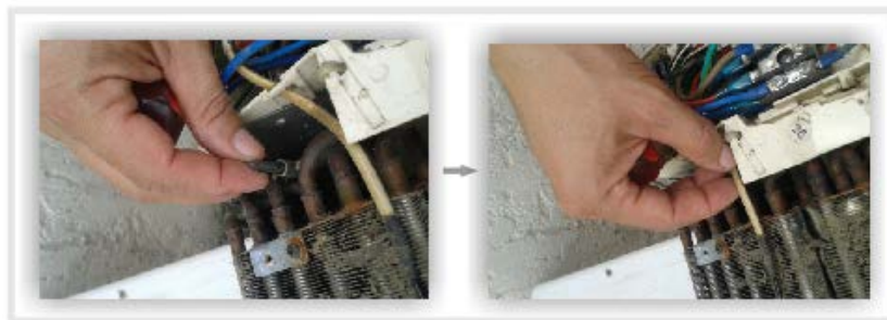
Figura 51. Retiro de sensores.
