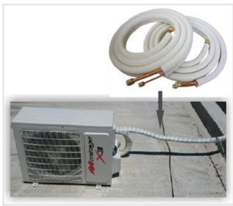
Figura 18. Aislamiento de tuberías.
