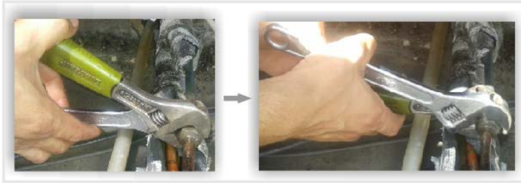
Figura 45. Desconexión de tuberías.
