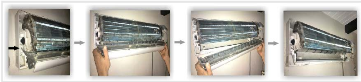
Figura 29. Retiro de bandeja de desagüe.
