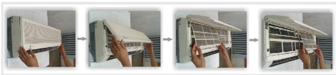
Figura 46. Retiro de filtros.
