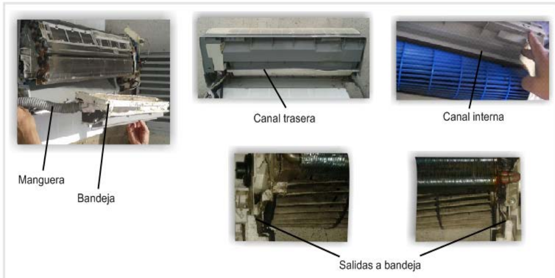
Figura 19. Partes de un sistema de desagüe.
