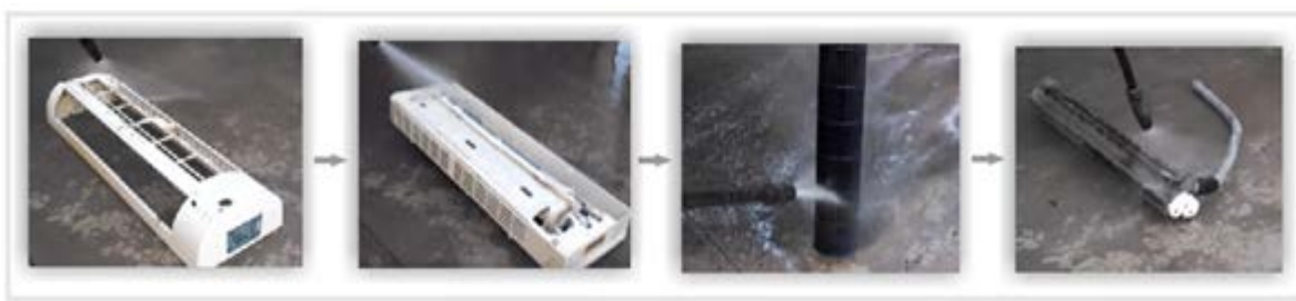
Figura 58. Limpieza de tapas, turbina, bandeja y manguera de desagüe.
